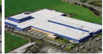
Hörmann KG Ichttershausen, Allemagne
